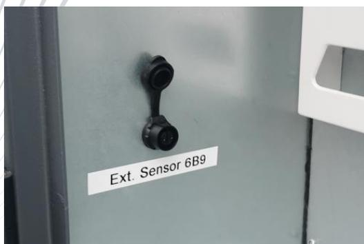
Im Inneren der Netzanschlusstüre befindet sich die, für den Raumthermostat vorgesehene Anschlussdose. Den Raumthermostat einstecken, bis die Federklemme einrastet. Sobald der Raumthermostat angeschlossen ist, wird dies in der WEB-Visu mit einem blauen Balken unterhalb des entsprechenden Symbols in der graphischen Darstellung angezeigt.
